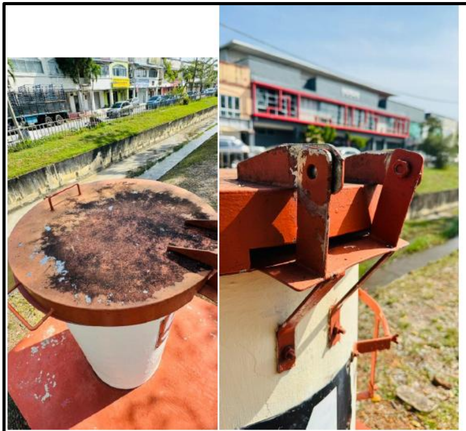
Gambar 8: Penutup Pilar yang perlu dicat semula dan diganti skru
